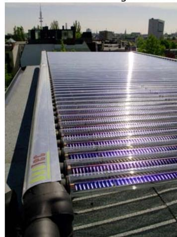
Undichtigkeiten am Dach fürchtet, die durch Befestigungsdurchdringungen entstehen könnten. Deshalb werden Flachkollektoren häufig mit Gewichten belastet um ein Abheben zu verhindern. Die zusätzlichen Lasten sind häufig so groß, dass die vorhandene Dachkonstruktion diese nicht aufnehmen kann. Das geplante Projekt wird dann oft verworfen, obwohl die Kosten pro Kilowattstunde Wärme konkurrenzlos günstig und CO<sub>2</sub> - neutral sind.
