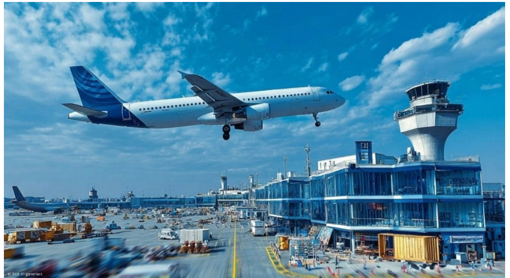
Als erster Flughafen in Deutschland erhält der Köln Bonn Airport die Zertifizierung nach VdS 3406 für ein ganzheitliches Sicherheitsmanagementsystem für bauliche Objekte.
