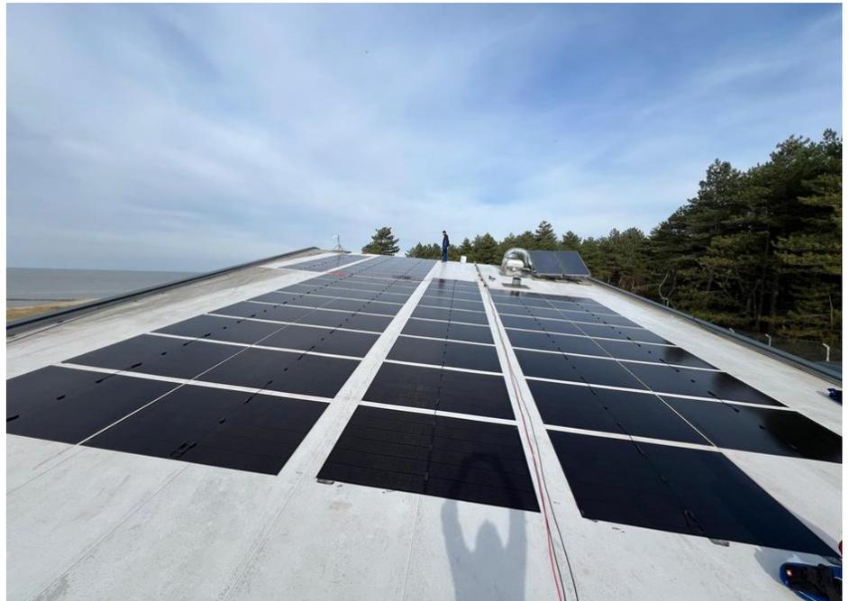
Für Dächer, die statisch nicht geeignet sind, um das Gewicht klassischer PV-Module zu tragen, bietet SunOyster Systems Leicht-PV-Module an.
