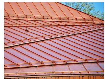
*RoofTech Ein- und Doppelrohr - Schneefang: teilweise schräg verlegt und farbbeschichtet.*
