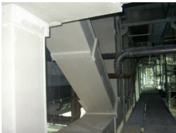
*Sicherheit in Planung und Ausführung: geprüfte Brandschutzkonstruktionen mit der vliesarmierten Rigips-Platte „Glasroc F“.*
