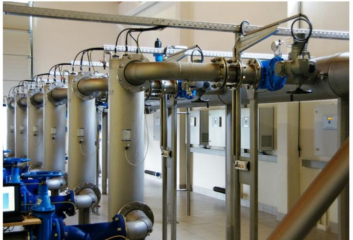
Aufgrund ihrer DVGW- und ÖVGW-Zertifizierung werden UV-Anlagen vom Typ Barrier S bevorzugt in Trinkwasserwerken eingesetzt, wie diese vertikal eingebauten Anlagen.
